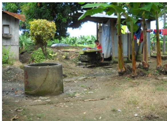
Figura 17. El pozo y la letrina a menos de 10 m de distancia uno del otro, y el nivel de la letrina es más alta que el nivel del pozo.
