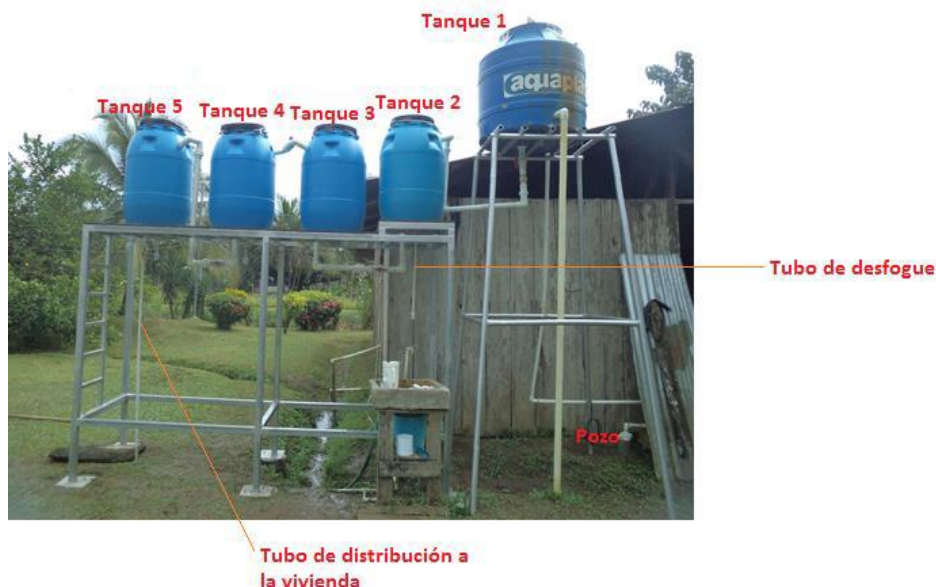
Figura 27. Sistema de remoción de manganeso y hierro, Monte Rey en Cariari de Pococí–Limón, 2014 (corresponde al prototipo piloto elaborado por Sthefany Hernández del TEC)
