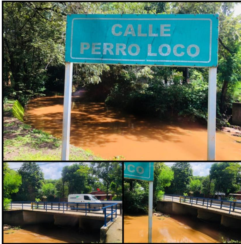
Figura 17 Tubería enterrada bajo el río en la Calle Perro Loco. Elaboración: Propia, 2022.
