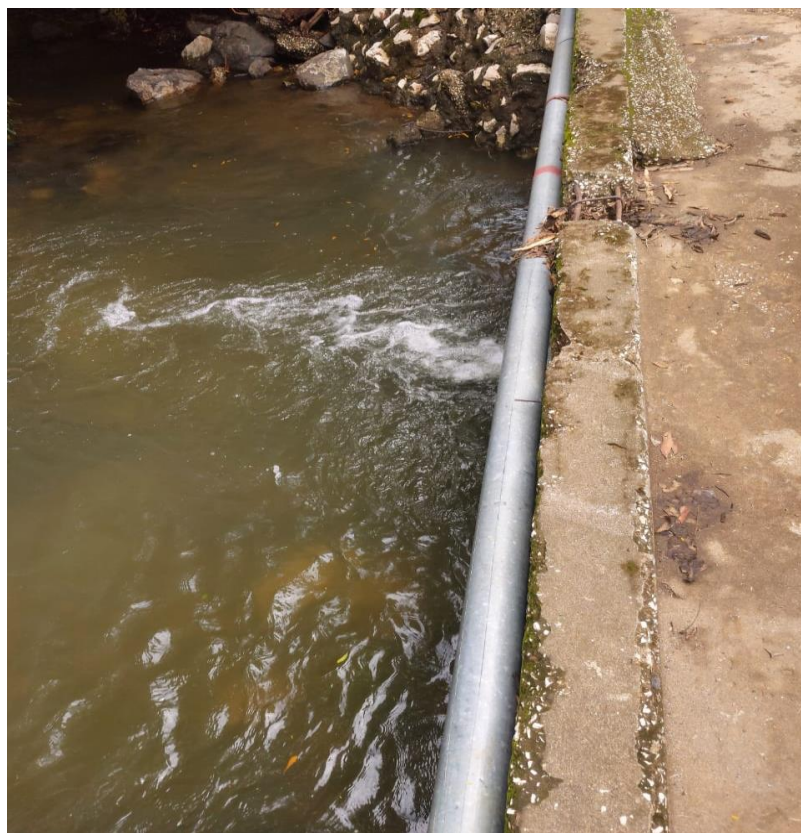
Figura 27 Paso elevado en el sector Pargos-Lagartillo. Fuente: Elaboración propia, 2021.
