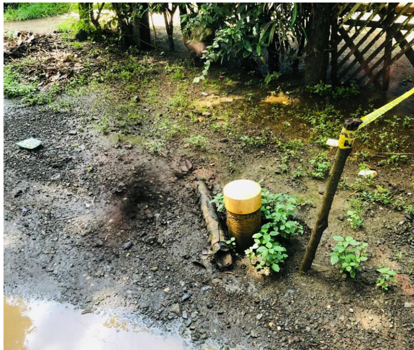
Figura 18 Ubicación de válvulas de aire en vías de tránsito de autos. Elaboración: Propia, 2022.
