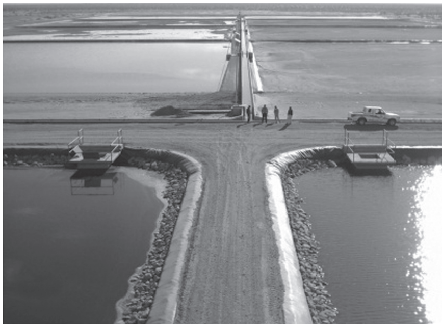
Figura 15. Lagunas de infiltración (al fondo).
