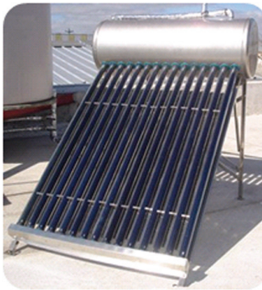
Sistema por termosifón y tubos de vacío
