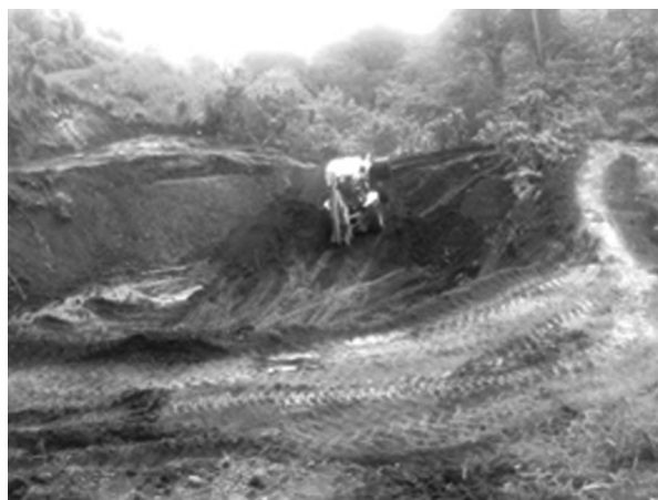
Figura 19. Construcción de reservorio en Cerro Negro, Santa Cruz, Guanacaste
