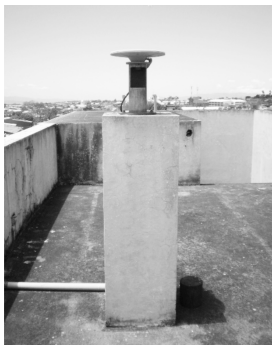
Figura 3. Pilar sobre el que se ubica la antena GPS
