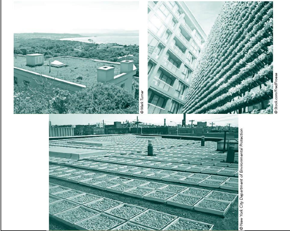
Techos y muros verdes y techos azules.
