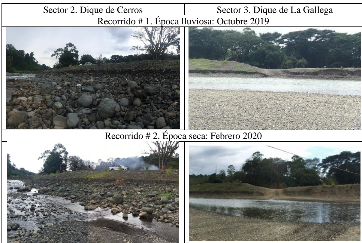
Anexo 18. Fotografías del trabajo de campo sobre los diques.
