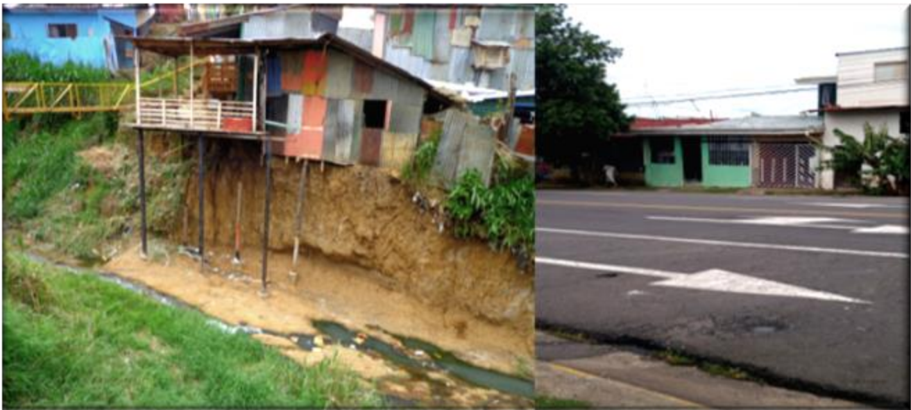
Imagen 12 Estado y materiales de vivienda en asentamiento informal y formal.
