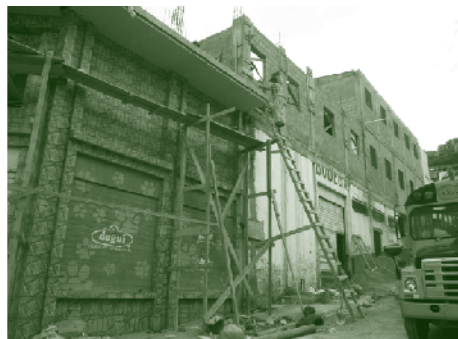
Bodegas en Avenida Comayagüela
