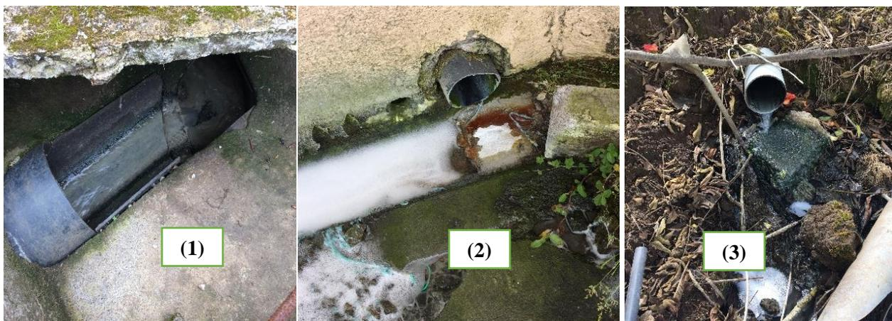
Figura 7. Puntos de muestreo dentro del HRCP. (1) Entrada a TSG. (2) Salida de ARR. (3) Salida de ARN.
