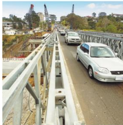
Los puentes bailey fueron colocados el 18 de noviembre del 2013. JORGE ARCE
