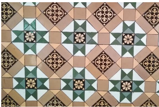
Figura D2.3: Pisos hidráulicos de la iglesia de San Rafael, Heredia. Nota: Catálogo fotográfico de esta investigación.
