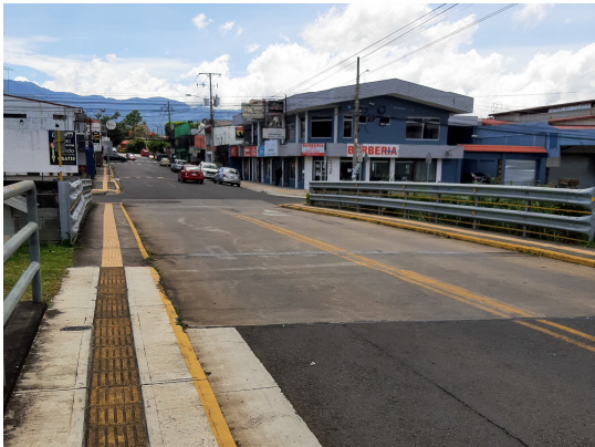
Fotografía 4: Puente sobre Río Quebrada seca, Belén. Captura propia, 2020.
