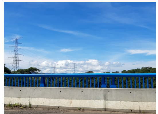
Fotografía 30: Puente sobre Río Virilla, Radial Santa Ana - Belén - San Rafael. Captura propia, 2020.
