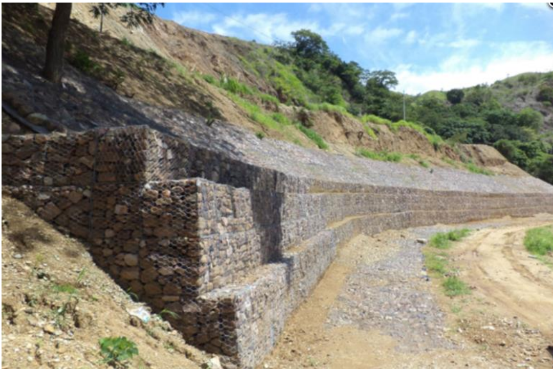
Imagen 34. Ejemplo de un muro de gavión de 130 m de largo para controlar la erosión de la margen derecha del Rio La Guama Tinaco. Cojedes, 2015.
