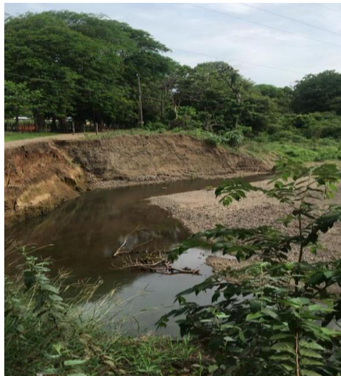
Imagen 2. Estado actual de la carretera que comunica el caserío “La Cueva del León” con la vía 931, Santa Bárbara de Santa Cruz, Guanacaste.
