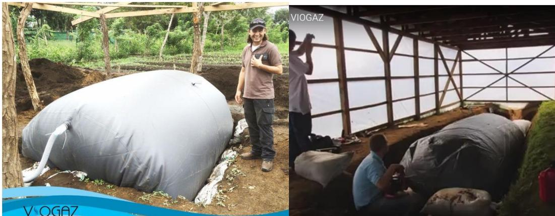
Biodigestores de plástico, tipo Taiwán, instalados por Viogaz en fincas pequeñas en Costa Rica. Fuente: <http://ecoinventos.com/viogaz-biogas-de-excrementos-animales/>
