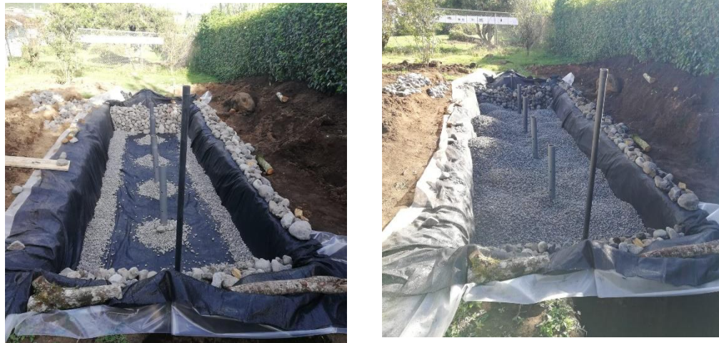
Figura 14. Colocación de relleno en la biojardinera. (a) Piedra bola. (b) Piedra cuarta.
