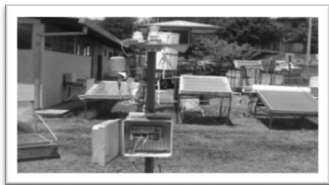
Figura 3. Sistema de adquisición de datos (data logger) utilizado en la toma de los datos de los radiómetros.
