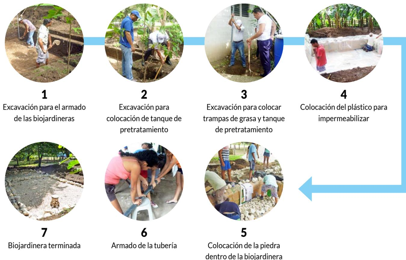
**Figura 12.** Proceso constructivo de una biojardinería
