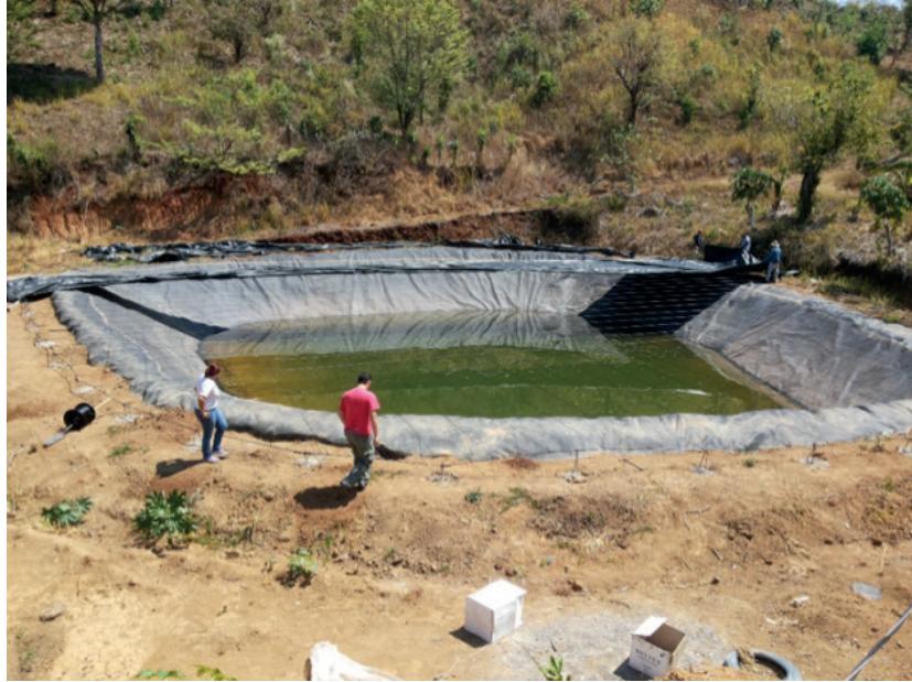
Figura 6 La familia Barrantes finaliza el revestimiento con sarán del reservorio con capacidad para 1500 m 3
