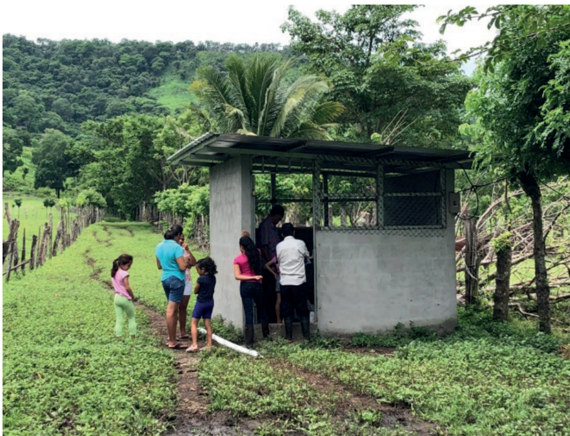
Figura 2 Casetilla construida alrededor del pozo en ASADA, La Y Griega
