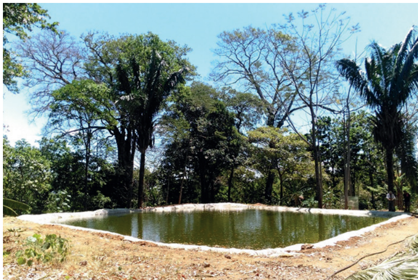
Figura 4 Reservorio finalizado de la familia Martínez con capacidad para 600 m 3
