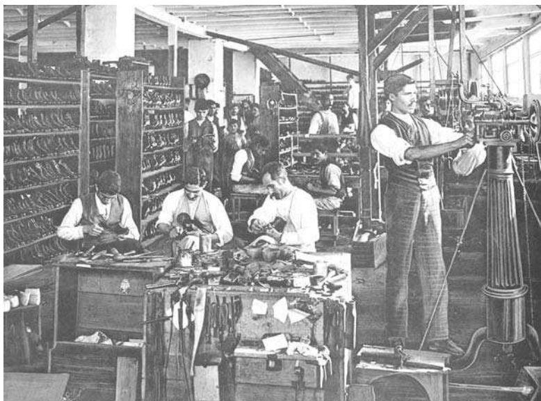
Fábrica de calzado en San José. Zamora, Fernando, Álbum de vistas de Costa Rica (San José, s. e., 1909), foto 39.
