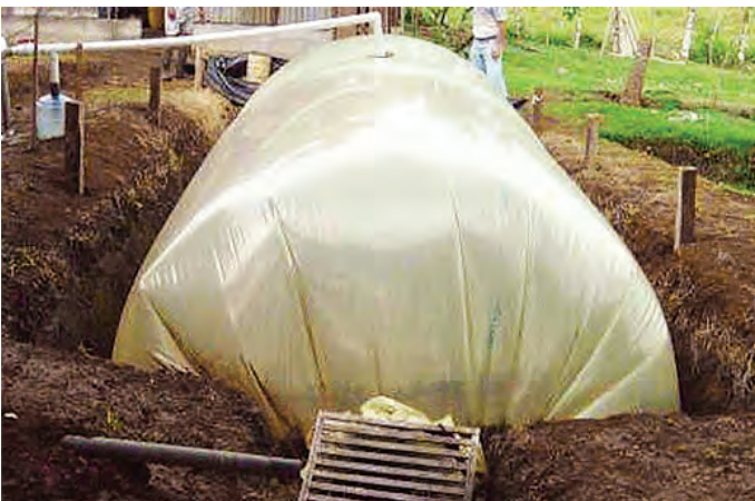
Biodigestor con biogas. Reproducido de Uribe et al 2011.
