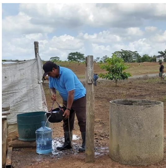
Figura 90. Pozo comunal. Tomada por Agua Viva Servis (2020).
