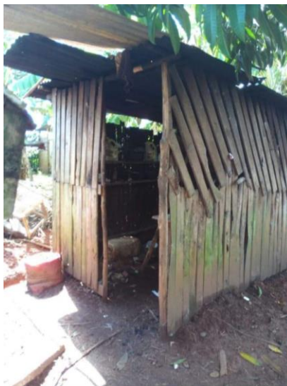
Figura 115. Piso de tierra. Tomada por Vanegas (2018)
