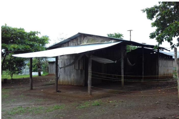
Figura 109. Ejemplo de edificación en la zona norte-norte. Tomado por Ugalde (2018)
