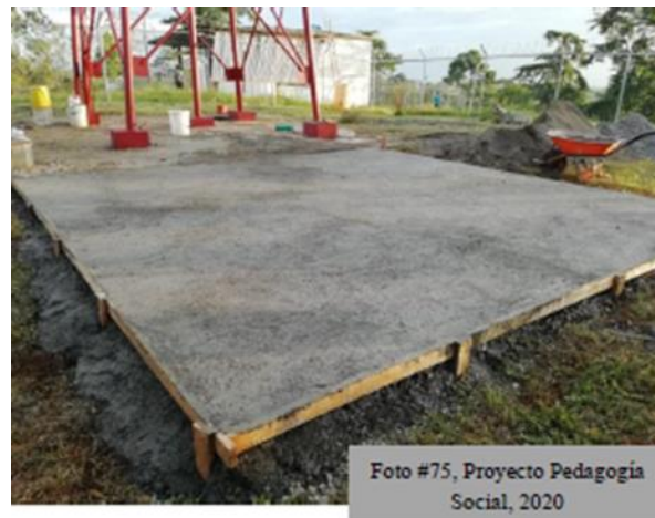
Figura 178. Base para el tanque de agua. Elaboración del Proyecto Pedagogía Social, 2021.
