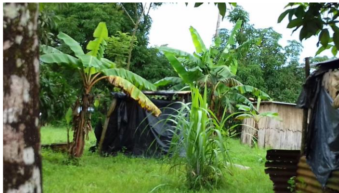
Figura 108. Ejemplo de edificación en la zona norte-norte. Tomada por Ugalde (2018)
